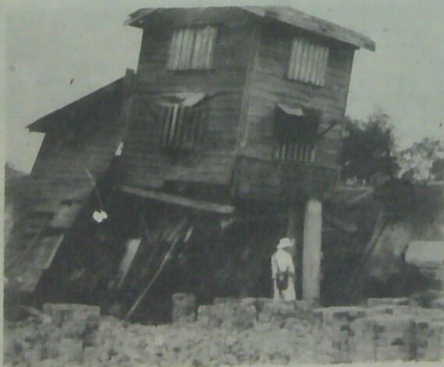
(5)、新化炸藥油廠向南 30^{\circ} 西傾倒 (35、12、23攝)
