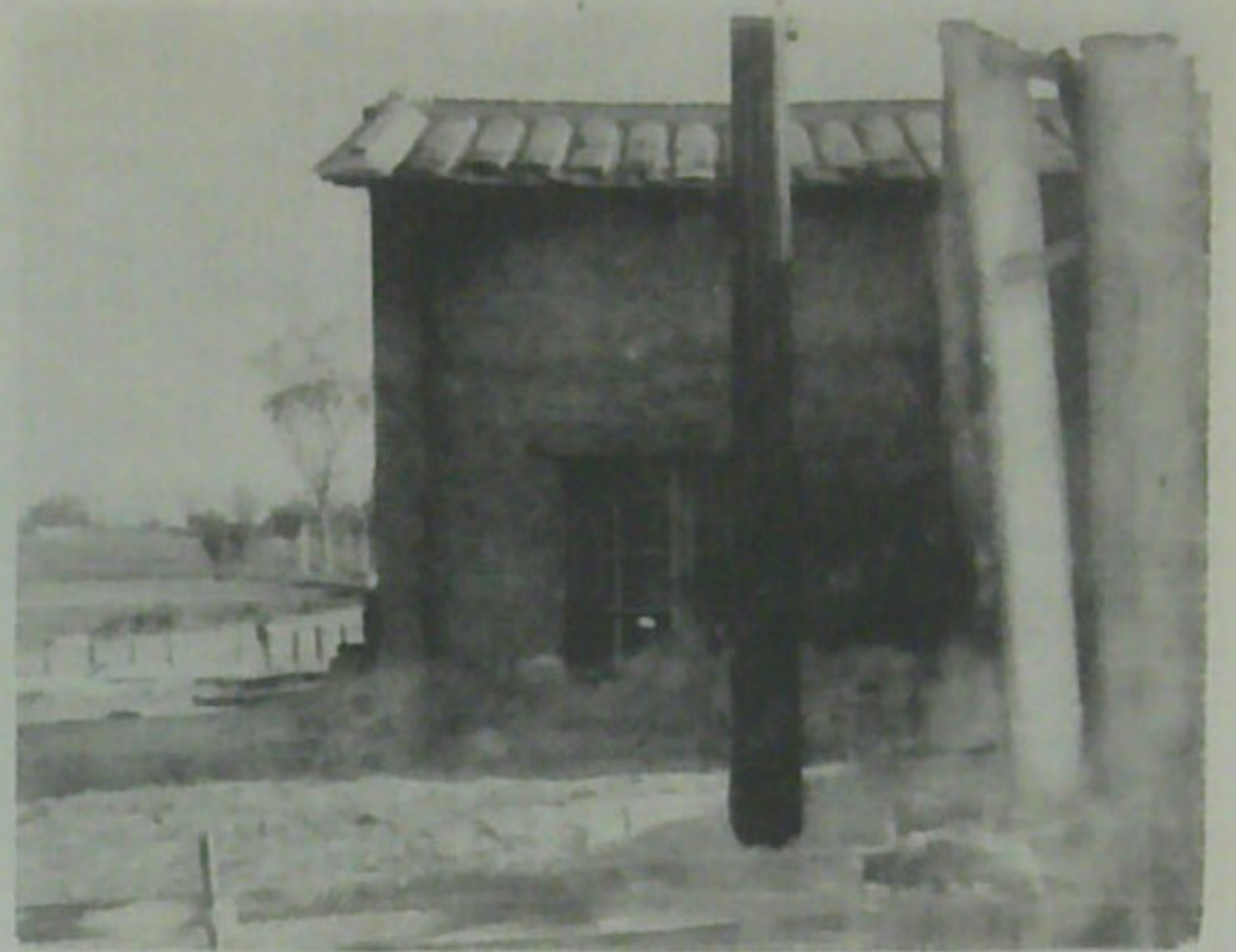
(2)、新市村房屋向北 50^{\circ} 東傾倒，殘 壁向北東東傾斜(同日攝)
