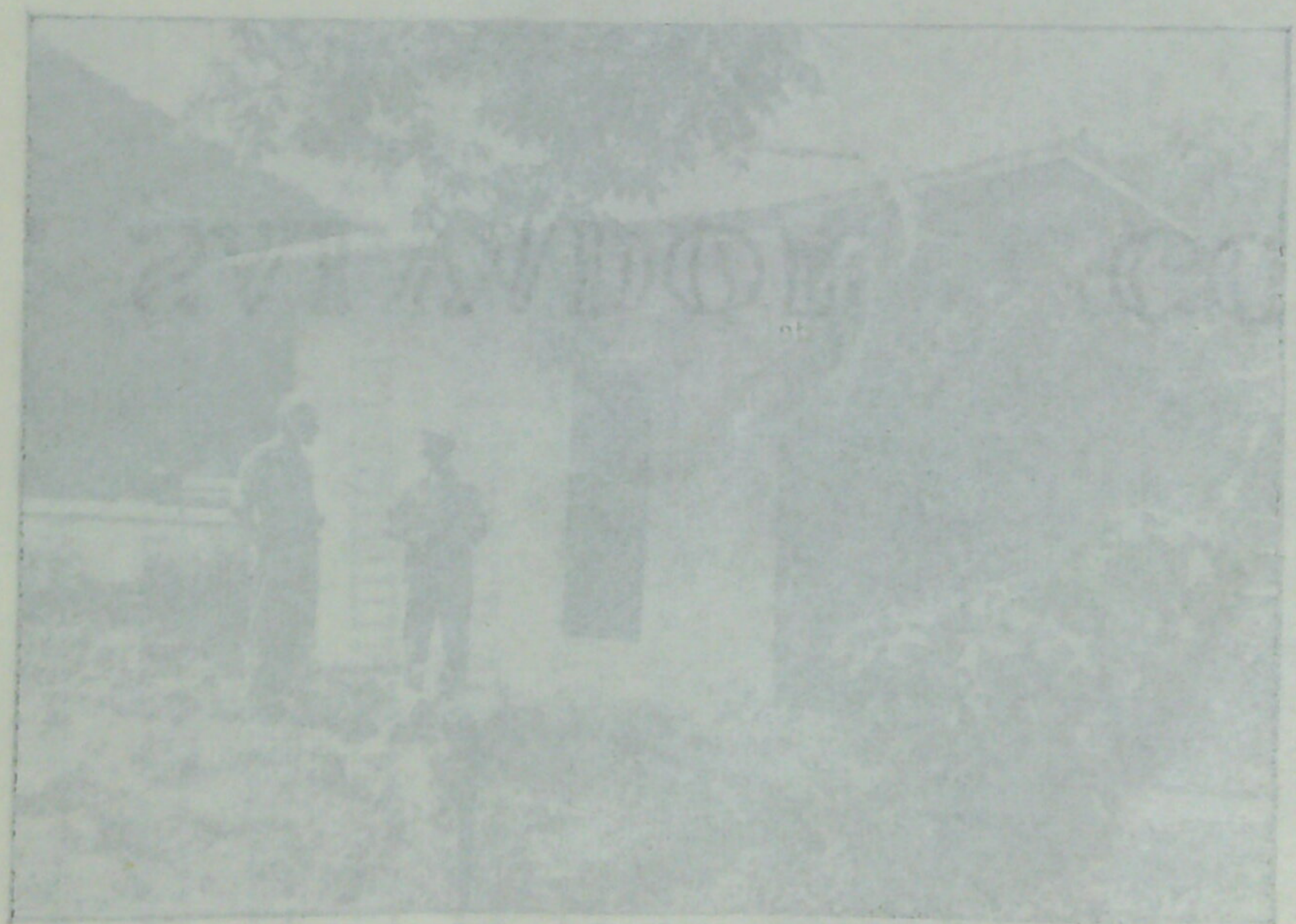
Fig. 4 Edificio Estación Simetría de Santiago de María.
